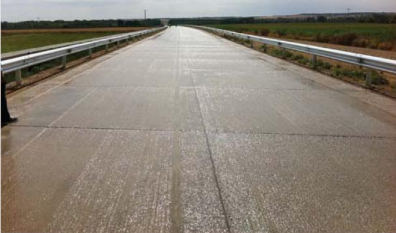
Pavimento de hormigón microfresado en Castilla y León, España
